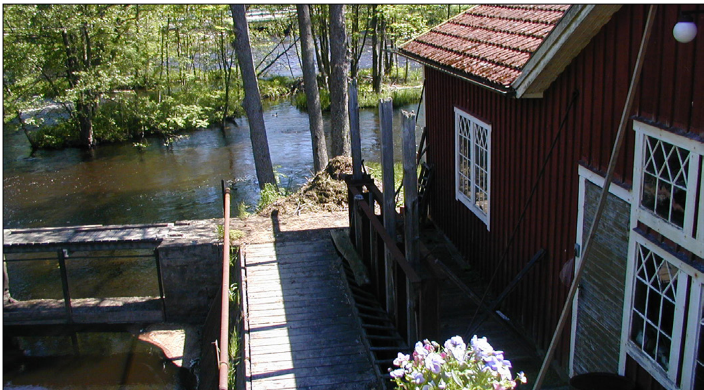
Kraftverket vid Ebbamåla Bruk. Foto: Ulrika Randver
